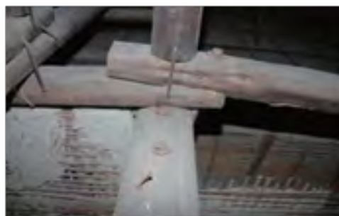
■ 屋架搭接以螞蝗釘固定
