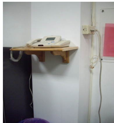
庫房電話設架置牆上
