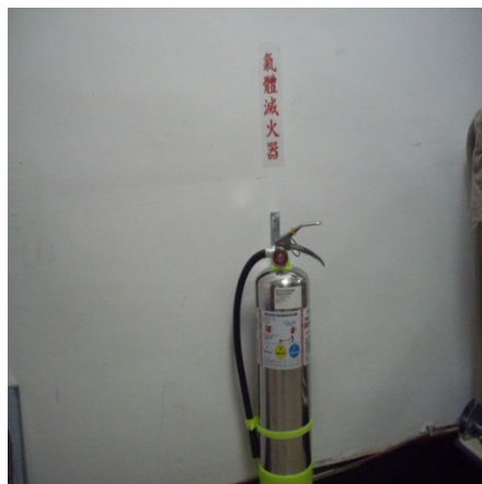
加裝氣體式滅火器
